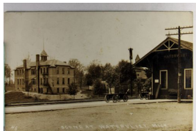
1418. Depot, Watervliet, Michigan, Real Photo, Used 1911 VF .. $30.00
