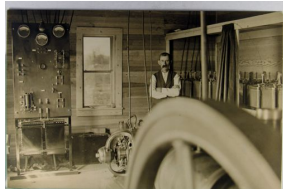
213. Machinery Incl. Batteries?, Real Photo w/Cyko P.C. back VF .. $120.00
