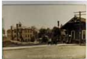
1418. Depot, Watervliet, Michigan, Real Photo, Used 1911 VF .. $30.00
